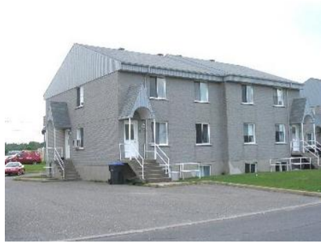
Construction : 1958 6 logements 730 A à 740 A Luc-Lacourcière, Lévis (Pintendre) Transaction : 2018-02-28, 687 500 $ (114 583 $/log.)
