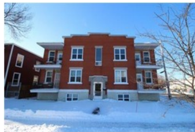
6 logements Construction : 1947 2085 Henri-Bourassa, Québec (Maizerets) Transaction : 2018-04-30, 415 000 $ (69 167 $/log.)
