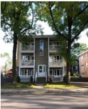
6 logements Construction : 1961 325 Chenes Ouest, Québec (Cité-Limoilou) Transaction : 2018-11-28, 508 000 $ (84 667 $/log.)
