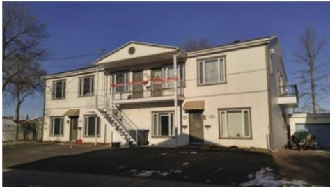
6 logements Construction : 1968 2237 à 2247 Ch. du Fleuve, Lévis (St-Romuald) Transaction : 2018-02-07, 482 000 $ (80 333 $/log.)
