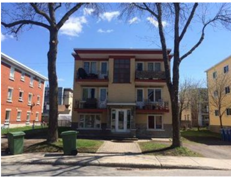
5 logements Construction : 1962 221 Chênes O., Québec (Limoilou) Transaction : 2018-06-28, 465 000 $ (93 000 $/log.)
