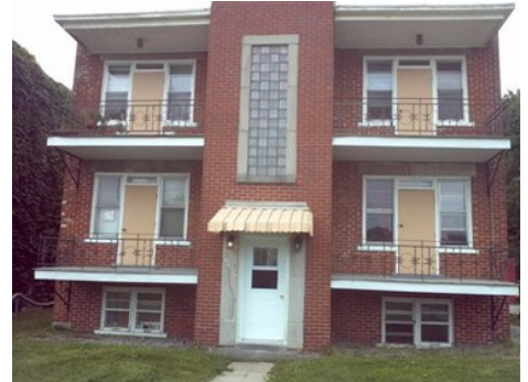
6 logements Construction : 1948 1735 Henri-Bourassa, Québec (Maizerets) Transaction : 2018-06-07, 425 000 $ (70 833 $/log.)
