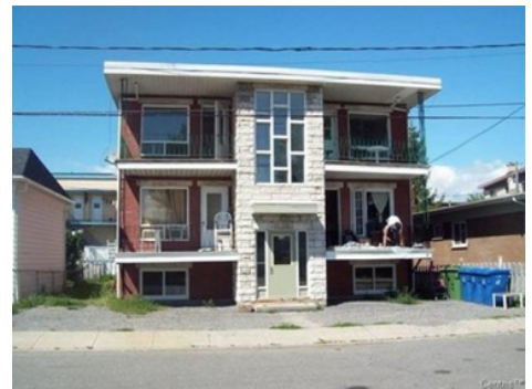
6 logements Construction : 1966 420 Aurèle-Cloutier, Québec (Les Rivières) Transaction : 2018-02-23, 492 000 $ (82 000 $/log.)
