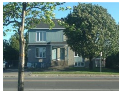
5 logements Construction : 1990 2090 à 2098 Seigneurs, Terrebonne Transaction : 2018-12-05, 612 500 $ (122 500 $/log.)
