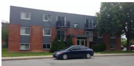
12 logements Construction : 1976 3495 Rivard, Laval (St-Vincent-de-Paul) Transaction : 2018-11-06, 1 475 000 $ (122 917 $/log.)
